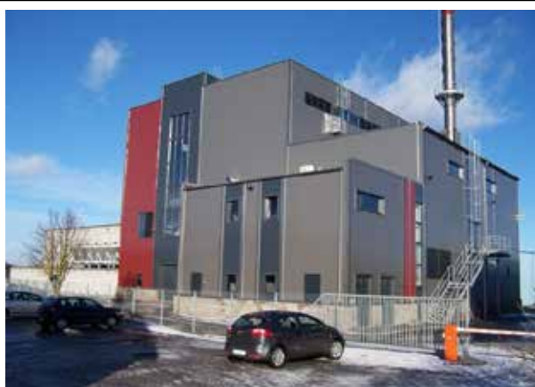
5.attēls. Kuresāres koģenerācijas stacija no ārpuses E
