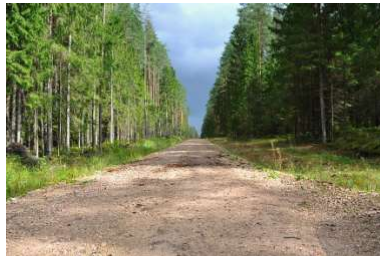
Būvēts meža autoceļš
